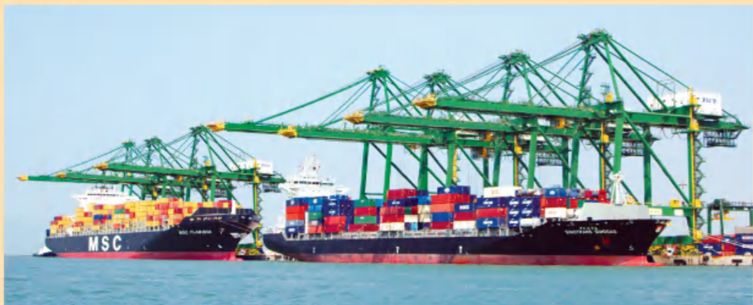
江阴港区列入福州市港口发展“南北两翼”集装箱核心港区；1-3# 泊位 983 米贯通交付
